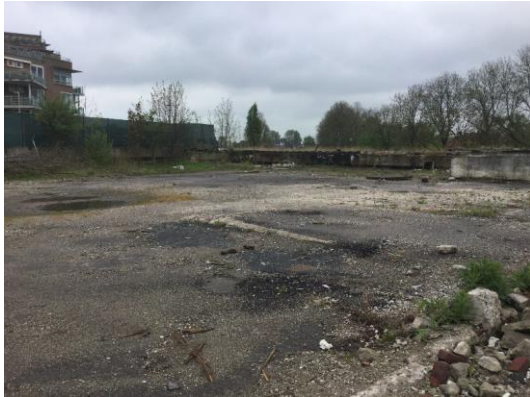
Puin verharding en los asfalt
