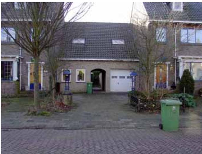
*Vensters/ deuren* : In de vensteropeningen bevinden zich stalen kozijnen met draairamen. In het meeste raamwerk is doorzichtig glas-in-lood in eenvoudige uitvoering verwerkt. Het brede deurkozijn rust op grote, vierkante neuten. In de ingang is een blankhouten deur met opvallend plaatwerk geplaatst.
