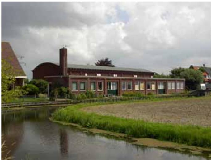
*Dak* : Betonschaaldak met bitumen, met een klein overstek naar alle kanten. Dakgoot op klossen aan de lange zijde van het hoofdgebouw. De aanbouw aan de achterzijde onder een plat dak. Schoorsteen op de hoek rechtsachter.
