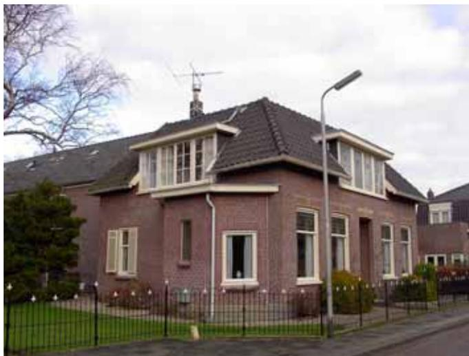
*Vensters/ deuren* : In zijgevels o.a. T-schuifvensters met glas-in-lood in de bovenlichten. In dakkapellen voorgevel en rechter zijgevel enkelruits draairamen met glas-in-lood. In dakkapel linker zijgevel 6-ruits draairamen.
