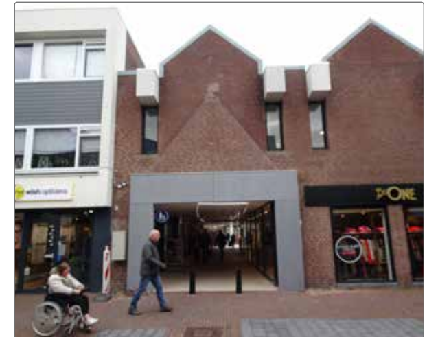
Entree Blokhuis: schakelpunt in de routing
