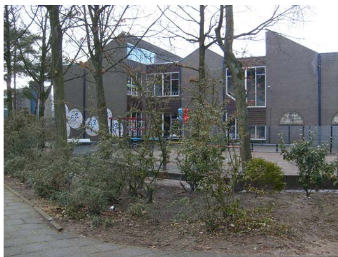
Afsluiting van de openbare weg door middel van beplanting.
