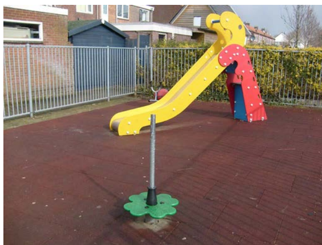
Het draaitoestel mist een knop bovenop de stang.
