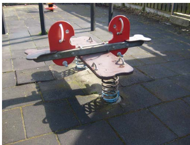
Ondergrond rubbertegels is in slechte staat. Ook toestel vertoont houtrot.
