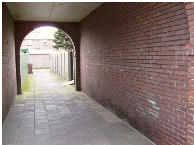
Onderdoorgangen langs de Nicolaas Damesstraat.
