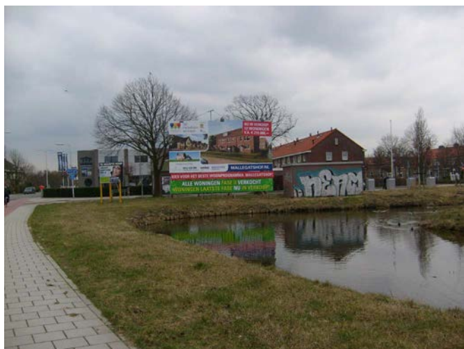
Er worden op dit moment nieuwbouwwoningen in De Engel gebouwd.
