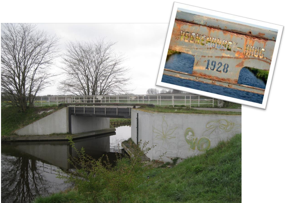
Figuur 12: Veenenburgerbrug in de Loosterweg Noord, die in 2020 zal worden vervangen - met detail van voor de laatste schilderbeurt.
